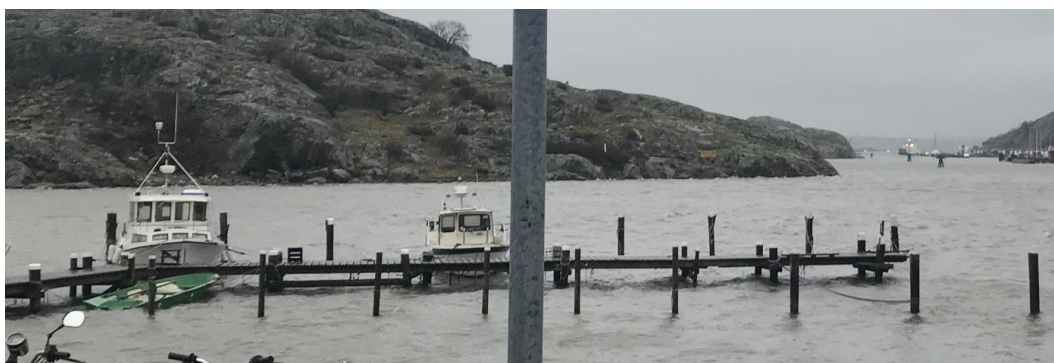
Figur 6. Befintlig småbåtsbrygga norr om kaj för persontrafik (Bildkälla: COWI AB).
