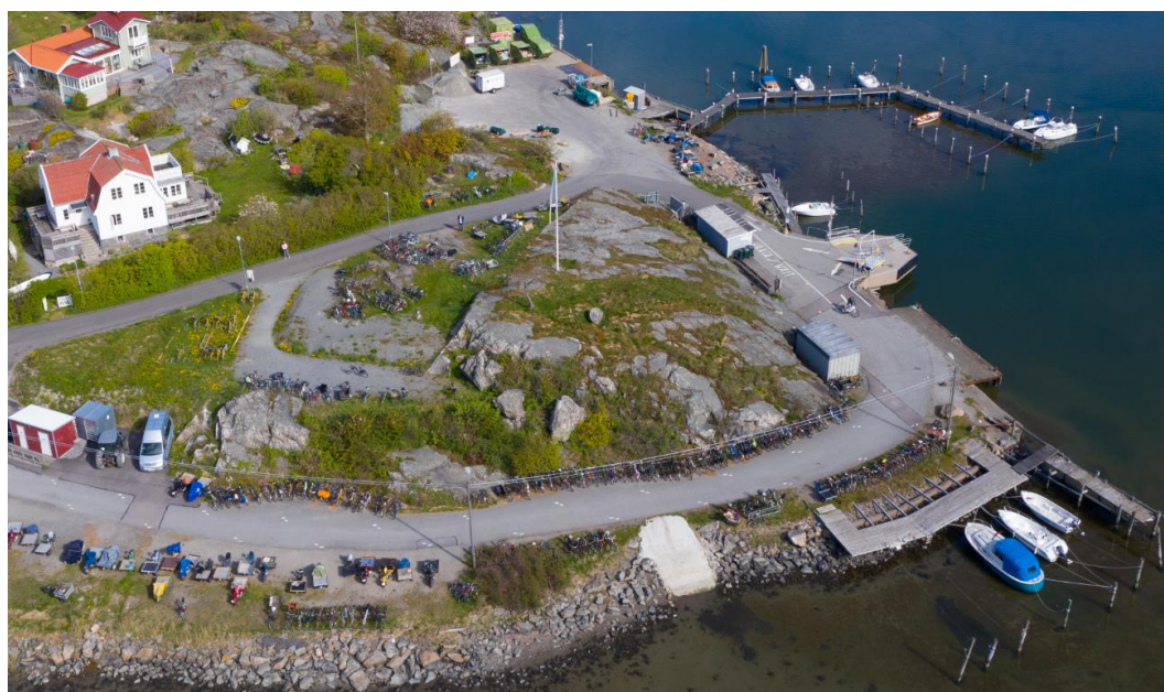
Figur 2. Flygbild över hamnanläggningen vid Brännö Rödsten (Bildkälla: Trafikkontoret, Göteborgs stad).
